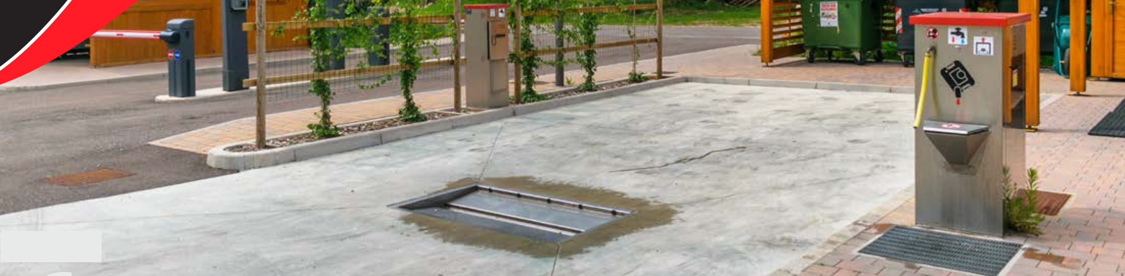
MODELLO S-210-F Lavaggio del pozzetto di scarico mediante fotocellula
